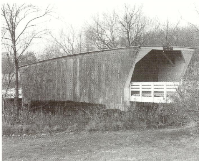
Cedar Bridge, Madison County, Iowa (15-61-03), le 13 novembre 1992 ©
