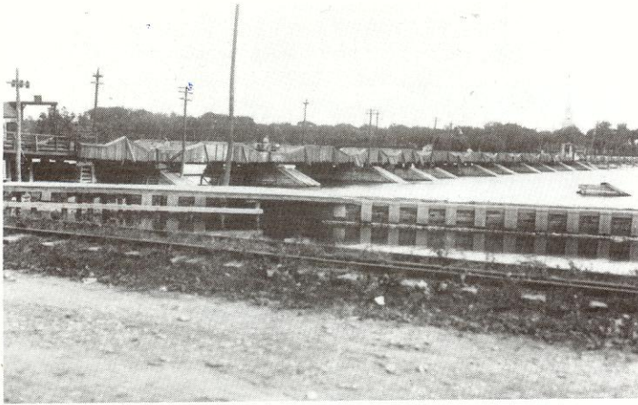
Pont Jones (61-28-P01/64-P01), rivière Saint-Jean sur Richelieu. Photo ANC PA 85726 ©
