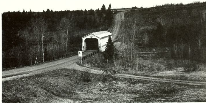
Pont Wellis-Leggett (61-18-09), sur la rivière Eaton, Saint-Isidore d'Auckland, construit en 1930. Photo: Gérard Arbour, mai 1984
