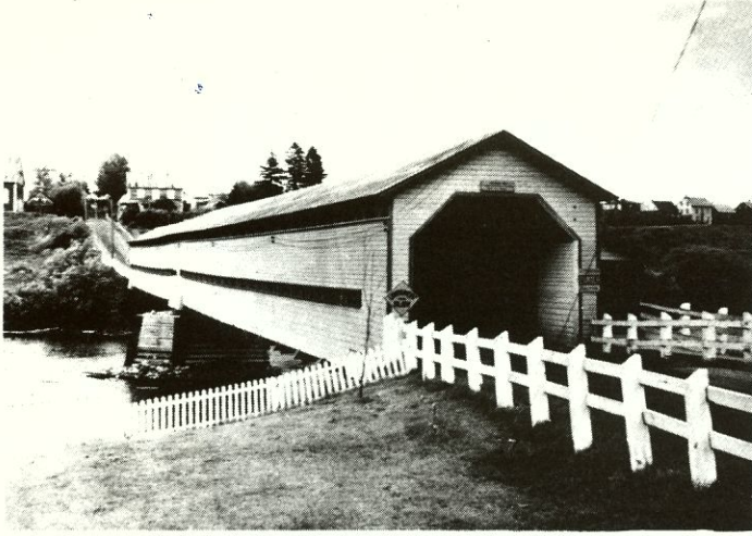
Pont du Village (61-13-01), sur la rivière Batiscan, à St-Adelphe, construit en 1924. Photo: Office du Film du Québec
