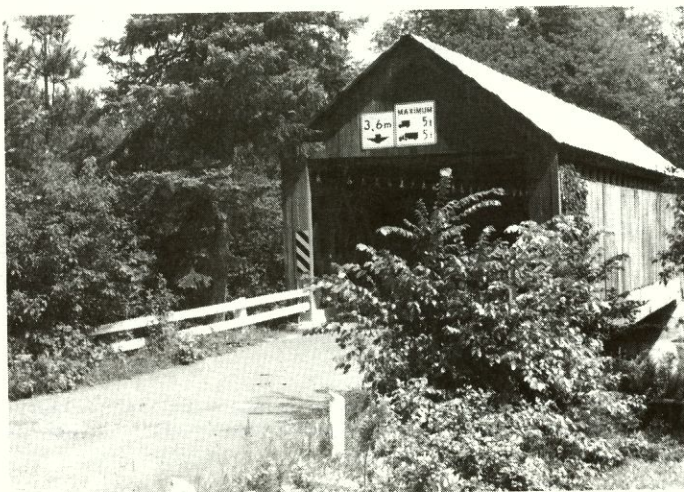
Pont de Milby (61-67-03), sur la rivière Moe, Canton d'Ascot, construit en 1872. Photo: Gaetan Forest, août 1988
