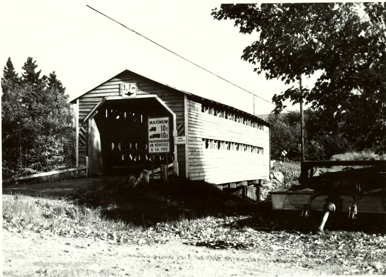
Pont Bolduc (61-06-02), sur le ruisseau Dupuis-Fortin, Sainte-Clotilde, construit en 1937
