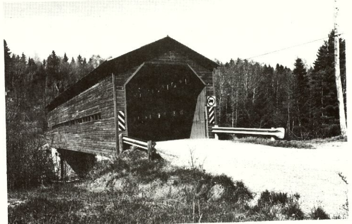
61-65-01 Pont de St-Mathieu, rivière Shawinigan, construit en 1936. Photo: Gaétan Forest, avril 1981
