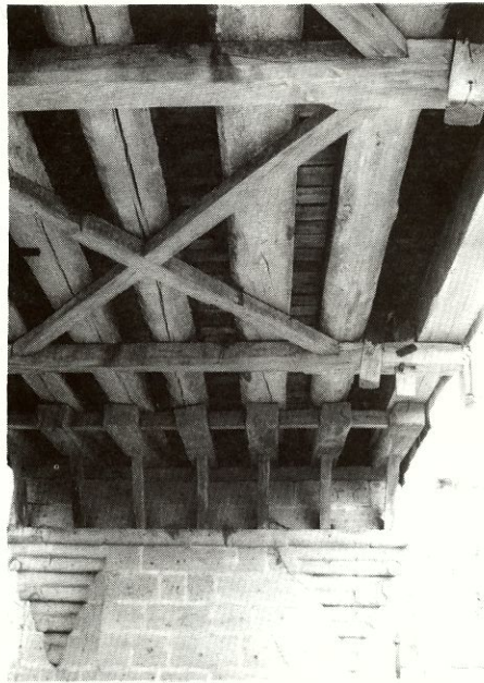
AARBERG, pont de 1568 à l'entrée ouest de la ville historique, sur la vieille Aare, la rivière qui a été détournée de 1872 à 1887 dans le lac de Biene pour éviter les inondations; l'intérieur du pont de Aarberg est typique des ponts du 16 ième siècle; charge limitée à 12 tonnes; la photo montre le dessous du pont dans son état original de 1568!
