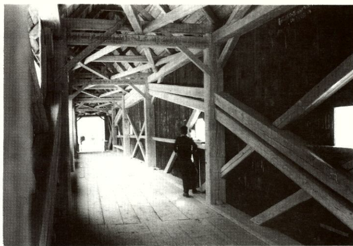
HUNDWIL, pont sur la rivière Urnasch érigé en 1778 par l'illustre Grubenmann; au nord du village à 20 minutes de marche! Hundwil est à 12km au sud-ouest de St-Gallen; la charpente, légère et élégante, est prévue pour porter des piétons.
