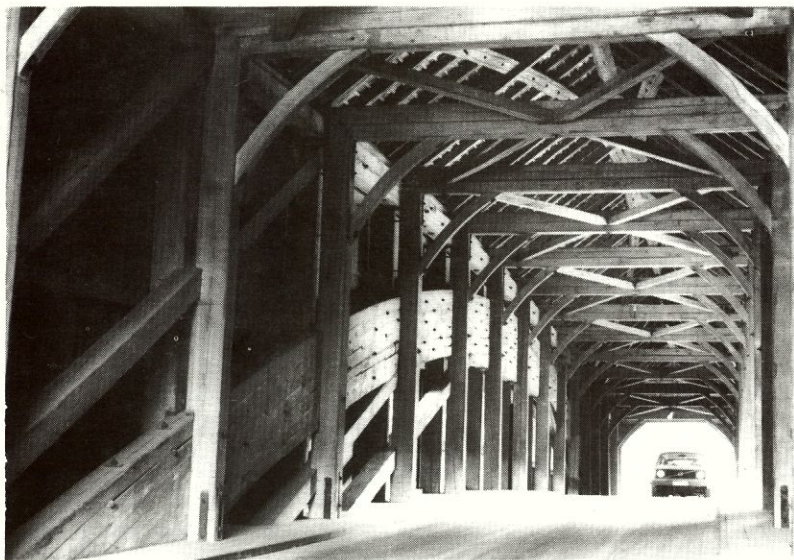
HASLE, pont de 1839 avec sa portée de presque 60m, un record des ponts historiques en Europe. Avant la grande crue de l'Emme en 1837 les ponts étaient appuyés sur plusieurs piliers, mais la plupart d'entre eux ont été détruits. L'arc est composé de 7 poutres à assemblage endenté pour offrir une résistance aux charges presque comme une pièce entière.
