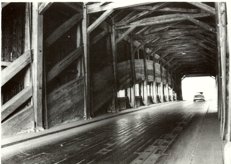
HASLE, pont de 1839 avec sa portée de presque 60m, un record des ponts historiques en Europe. Avant la grande crue de l'Emme en 1837 les ponts étaient appuyés sur plusieurs piliers, mais la plupart d'entre eux ont été détruits. L'arc est composé de 7 poutres à assemblage endenté pour offrir une résistance aux charges presque comme une pièce entière.
