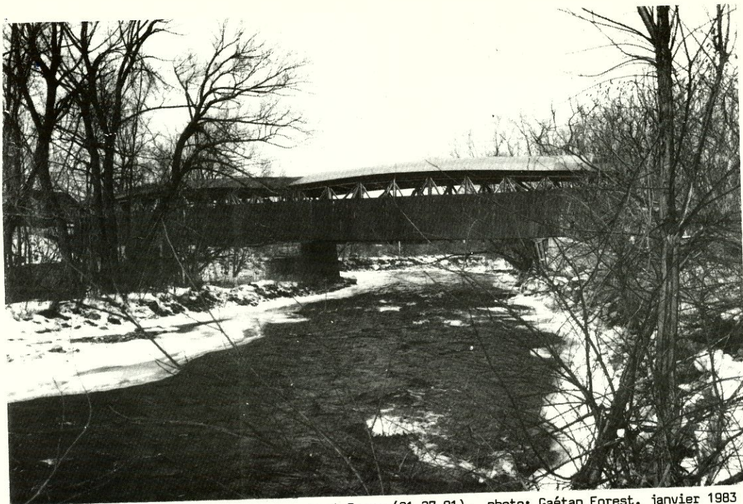
Pont Percy (61-27-01), photo: Gaétan Forest, janvier 1983
