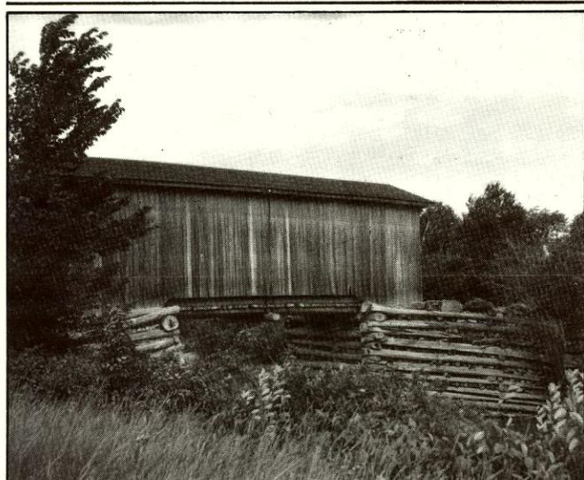
*Quel type de charpente cache ce petit pont couvert? Sa courte portée laisse supposer qu'une ferme à poinçon simple supporte son tablier. Le découpage caractéristique de son lambris le prouve. De plus, il est fréquent de voir de telles charpentes bâties sur des assises faites de simples billes de cèdre. Saint-Donat-de-Rimouski, (61-58-13).
