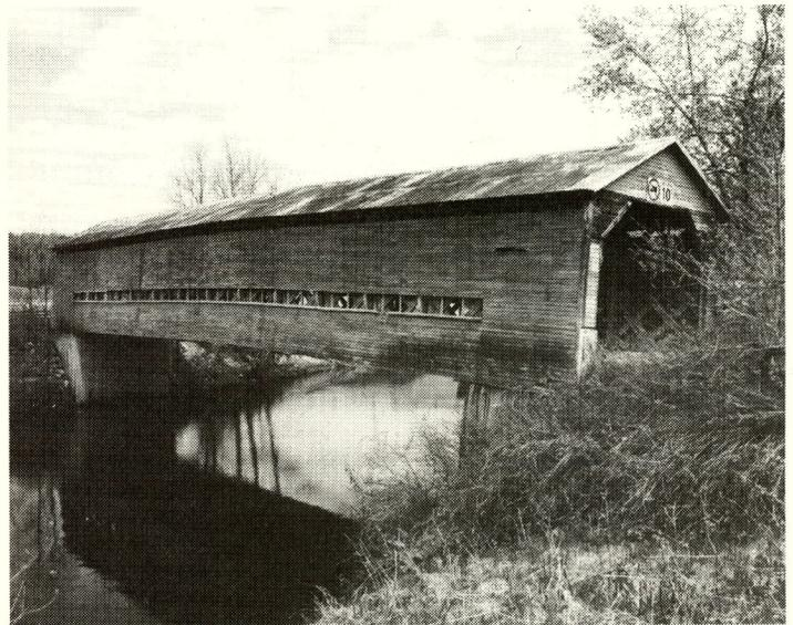
61-41-01. Pont du Ruisseau Plat, Sainte-Ursule, comté de Maskinongé. Construit en 1924, sur la rivière Maskinongé, le pont a été partiellement détruit par un incendie en août 1985.
