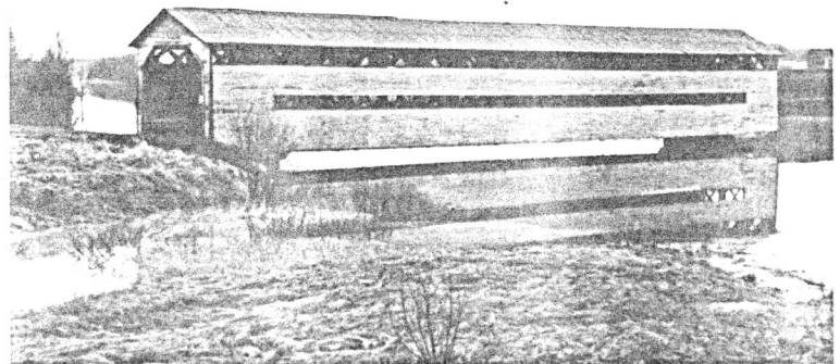
61-01-08 - Pont Vautrin, Preissac, demoli. (Photo: Pierre Duff, 1976)
