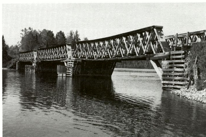
Le pont Nord-Est de type triple-Warren. Photo: Gaétan Forest 1994 ©
