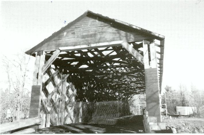
Le pont Balthazar lors des réparations. Photo : André Cloutier ©
