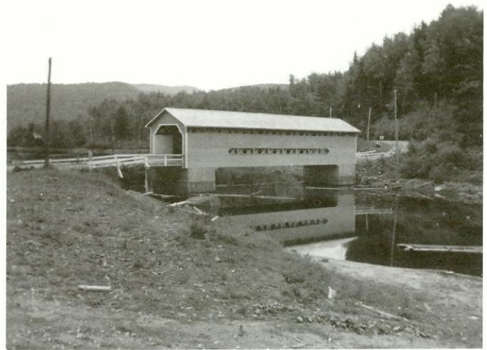
Le pont du Serpent #2 (61-33-39) retrouve son comté d'origine.
