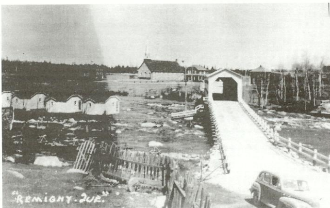
Le pont «chapelle» des Rapides (61-70-13) et l'église neuve en arrière-plan. Photo : collection Gérald Arbour.
