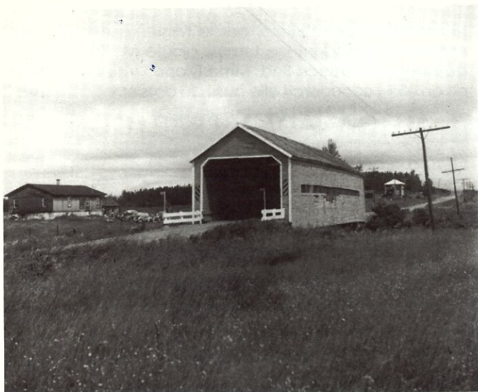
Un des ponts de Taschereau (61-02-31) peu de temps avant son remplacement. Photo: Joseph D. Conwill ©
