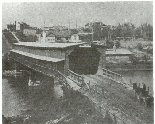
Le pont d'Amos (61-02-40) Photo collection L.P. Gravel
