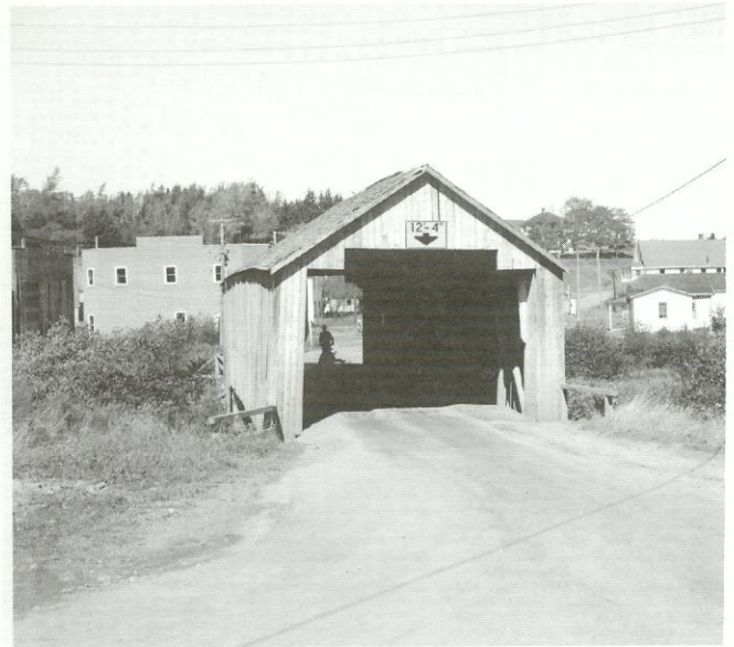
Le dernier pont couvert de Nouvelle-Écosse à Kennetcook. Remplacé en 1968. Photo: © Raymond Brainerd
