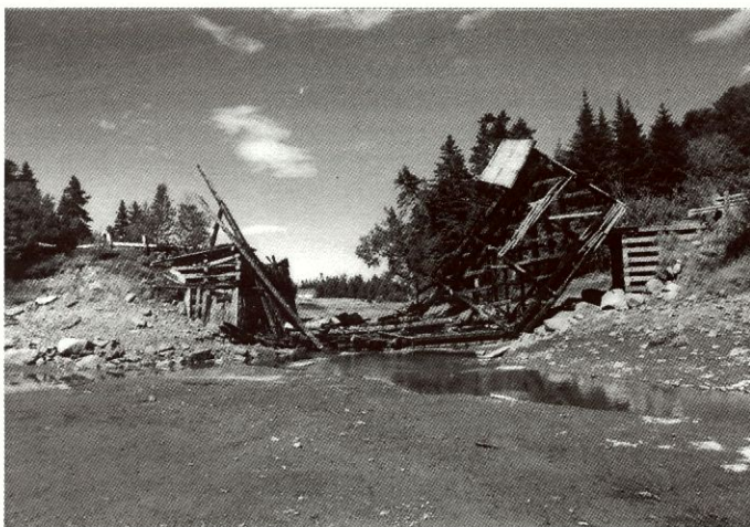
Les ruines du pont de la Rivière-Hatée le lendemain du désastre.
