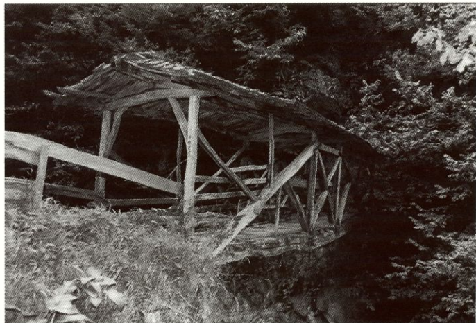
Un des ponts du ruisseau Uzungol.
