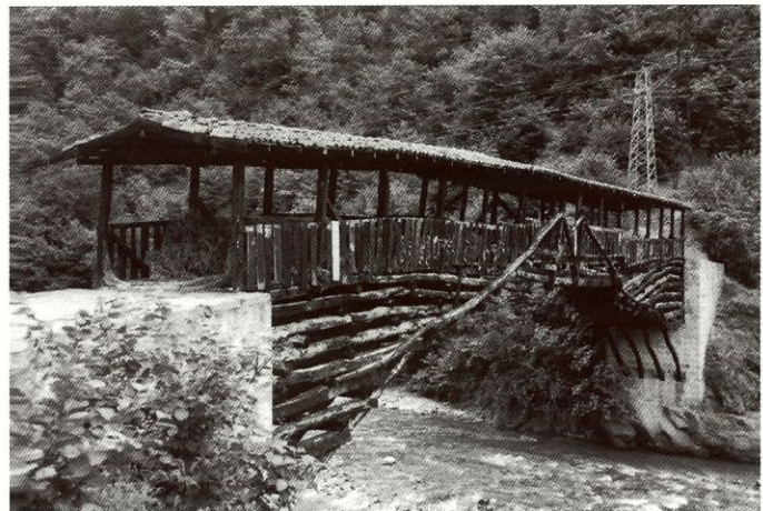
Le pont sur le fleuve Solaklidere.
