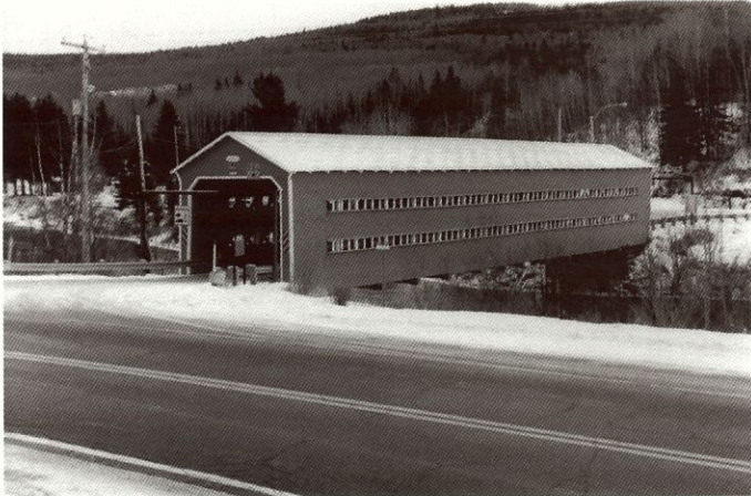
Le pont Thiffault (61-37-03) Photo: André Cloutier ©
