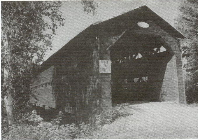
Pont Saint-Placide-de-Charlevoix (61-14-03) Photo: Éric Clusiau ©
