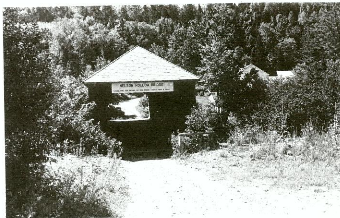
Le pont Nelson Hollow avant les grands travaux de 1997.
