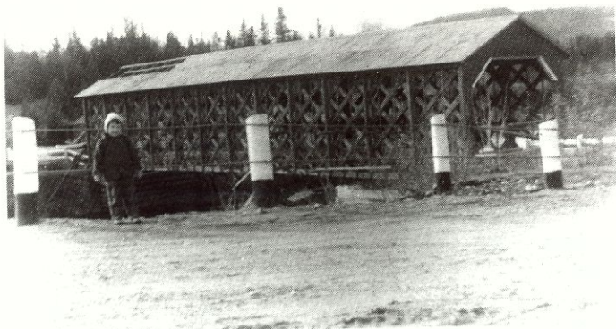
Pont-Rouge (61-31-18). À sa démolition en 1958 Photo: Jean-Marc Jeanson ©
