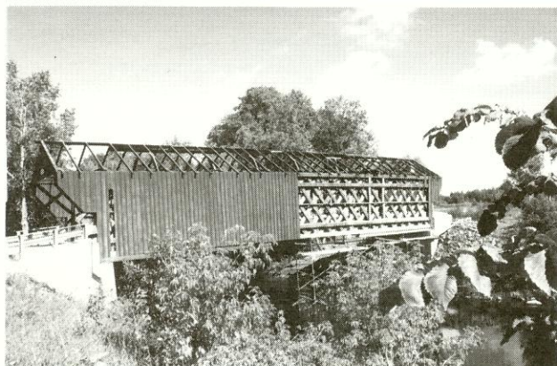
Travaux à Cowansville (61-45-02), septembre 1997. Photo: Léo Bonin ©
