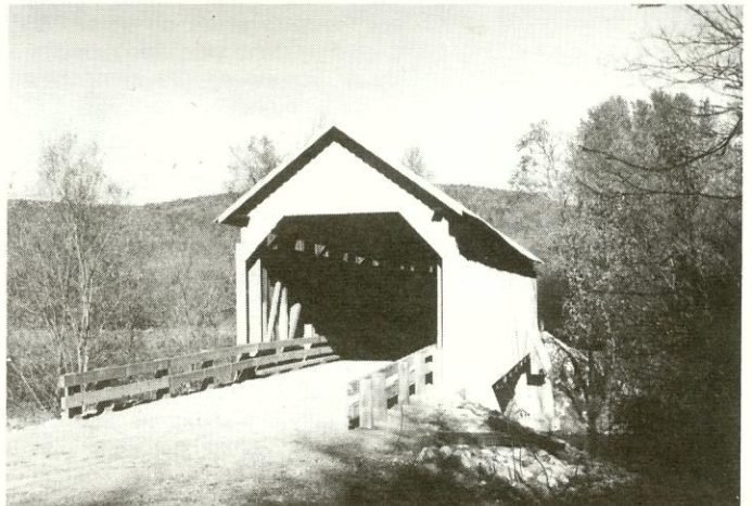
Travaux à Eustis (61-18-02) terminés octobre 1997. Photo: Léo Bonin ©
