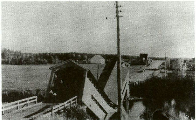
Vue du pont quelques minutes après l'effondrement. Photo: Raoul Roy ©
