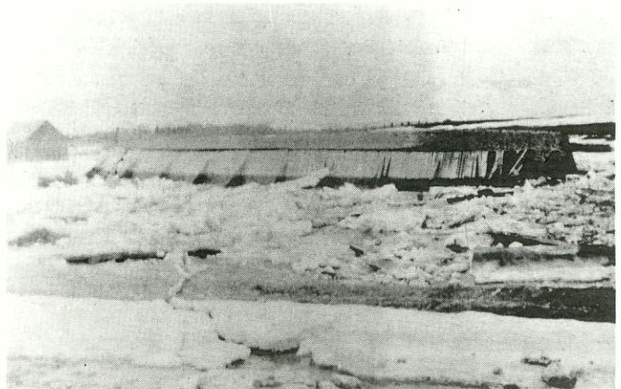
Le premier pont Doucet (61-60-36) terrassé par les glaces de la rivière Ticouapé. Photo: Doucet.©
