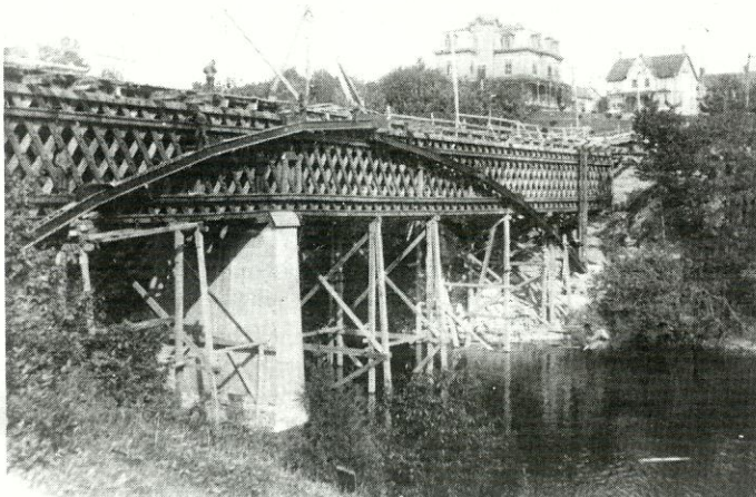
Le pont Wolfe (61-67-09) (pour automobiles) de Sherbrooke était une structure de type inférieur. Les côtés étaient recouverts et le tablier faisait office de toit. S.H. des Cantons de l'Est.
