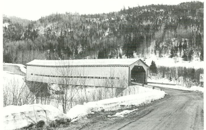
Le pont Louis-Gravel (61-62-01) est un de ceux qui «espèrent» recevoir toute l'attention nécessaire dans un proche avenir. Photo:Gérald Arbour, 1985. ©
