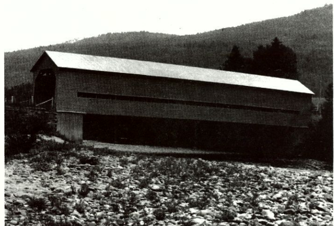
Le pont du rang Cran-Blanc (61-14-01) à une époque où il avait encore fière allure.
