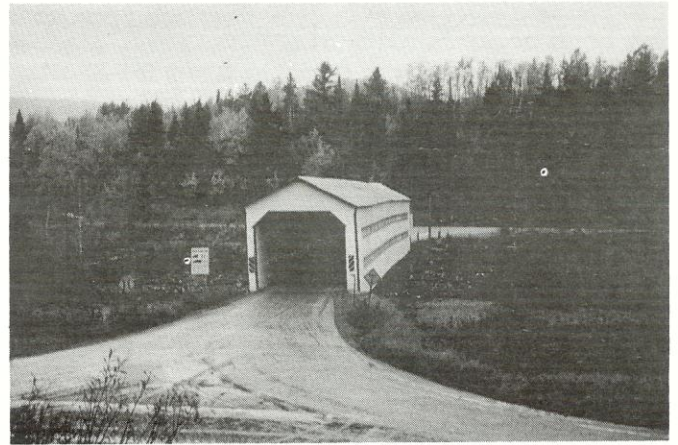
Situé à un carrefour, le pont Thiffault (61-37-03) célébrera son 50 e anniversaire de construction en 1996.
